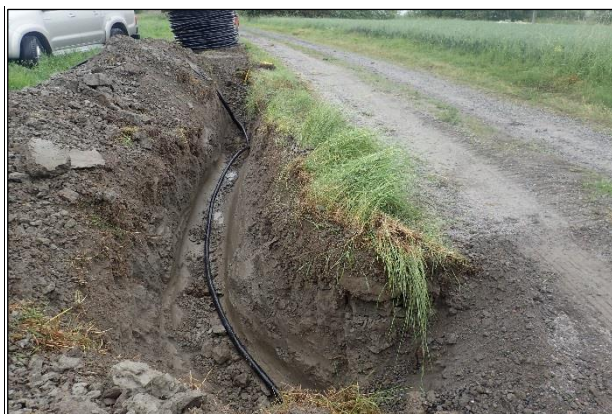
Vasen: Kaivuu aloitettiin Sarvunlahdentieltä, josta ojaa jatkettiin tien poikki etelään. Oikea: Maakaapelilinjan eteläinen osuus kaivettiin viereisen pellon reunaa myötäillen.
