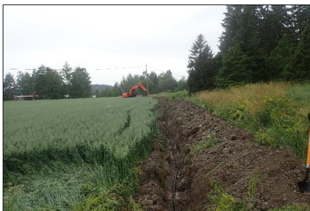
Vasen: Kaivuu aloitettiin Sarvunlahdentieltä, josta ojaa jatkettiin tien poikki etelään. Oikea: Maakaapelilinjan eteläinen osuus kaivettiin viereisen pellon reunaa myötäillen.
